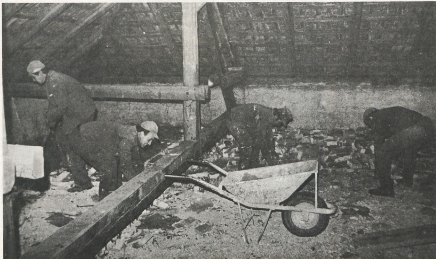
Delavci IVS so pričeli prejšnji mesec adaptirati podstrešje in streho nad staro upravno zgradbo. Na sliki: odvoz stare šare in razbitih opek.
