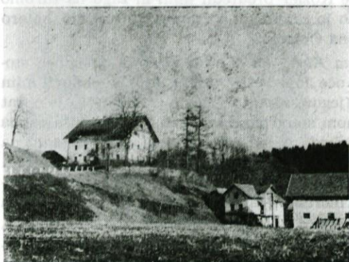
Karlovica in nekdanji Podkarlovški mlin (srednja stavba)
