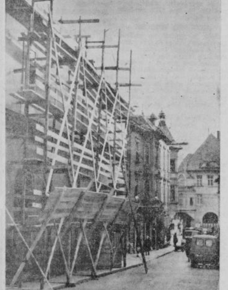
Zgradba ptujskega gledališča je morala dobiti v najhujši zimi krepke železne vezi, ki bodo varovale južni zid pred nadaljnjim odkimkanjem od drugih zidov. Sedaj ni več opazev, vidi se pa še vedno, da v zimi vseh del ni bilo mogoče končati.
