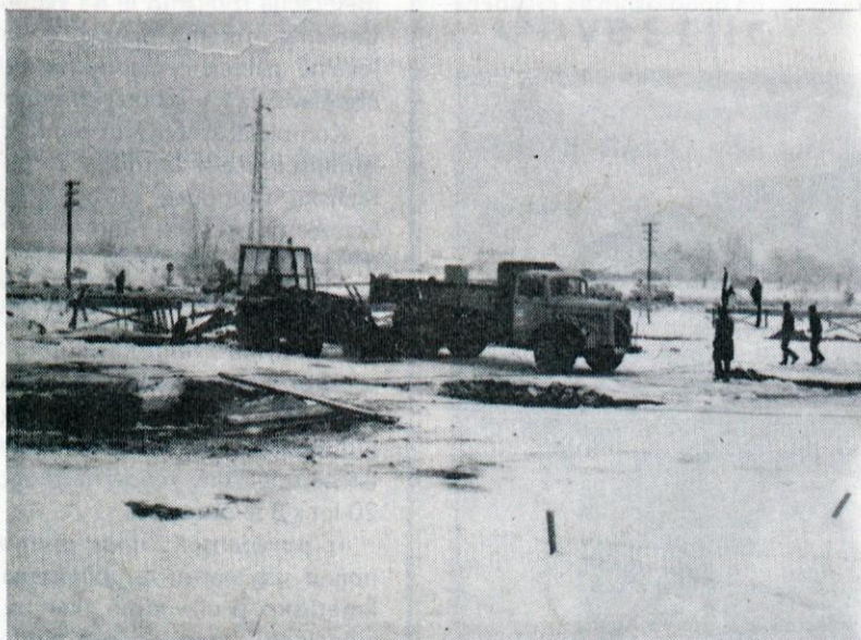
Kralovške. Po štirih letih, toliko časa je namreč čakalo sanirano zemljišče, so tudi zabrnili stroji. Upamo, da bo objekt res gotov do začetka prihodnjega leta!
