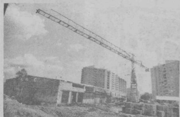
Na sliki: Preskrbovalni E-center v gradnji med staro in novo Zaloško cesto (Foto: Dušan G.)
