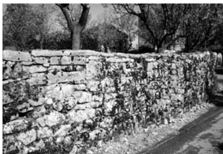
Podporno-razmejitevni zid št. 9 z nadomestnim zaključkom horizontalno postavljenih škrl.
