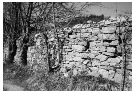
1,7 do 2 m visok razmejitevni zid št. 12 med klancem in kmetijskim zemljiščem, skoraj gotovo delo poklicnih zidarjev.
