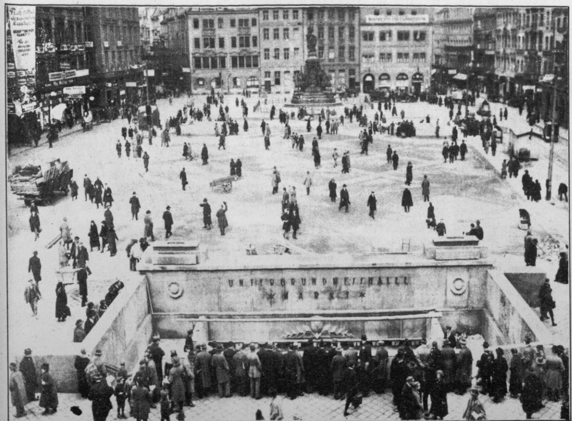
Vhod v podzemeljske prostore velesejma v Lipskem.
