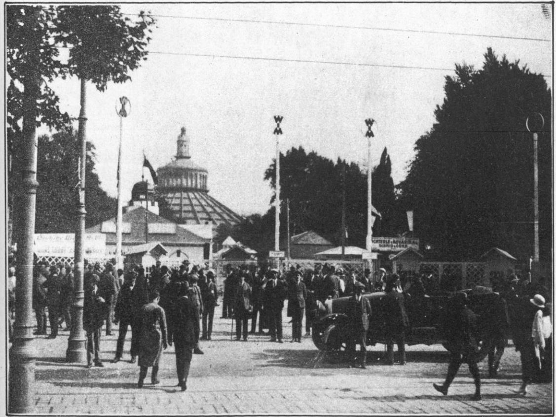
Pogled na zapadni vhod tehniškega oddelka dunajskega velesejma
