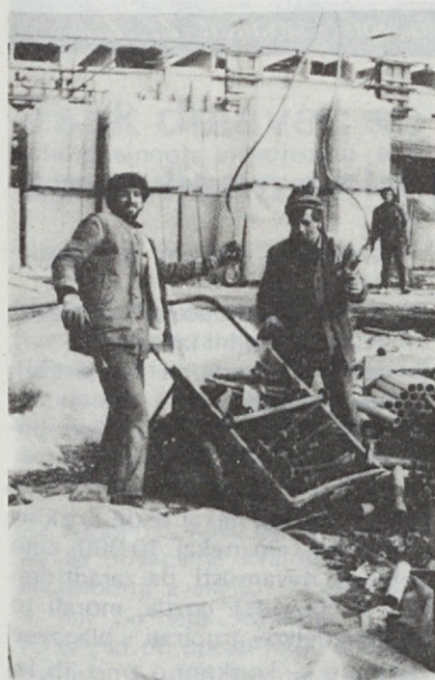
Delavci Gradisa hitijo z delom saj se rok izgradnje hitro bliža
