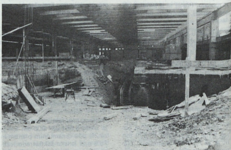
Dela pri zasilnem izhodu iz zaklonišča v kleti
