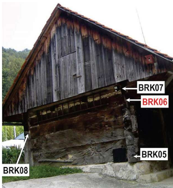
Slika 1. Berkovičev hram in delovne številke brun, iz katerih smo odvzeli izvrtke za dendrokronološko datiranje. Bruno BRK06 je imelo na delu na vhodnih vratih vrezano letnico 1722 (Foto: K. Čufar 4. 8. 2004).
