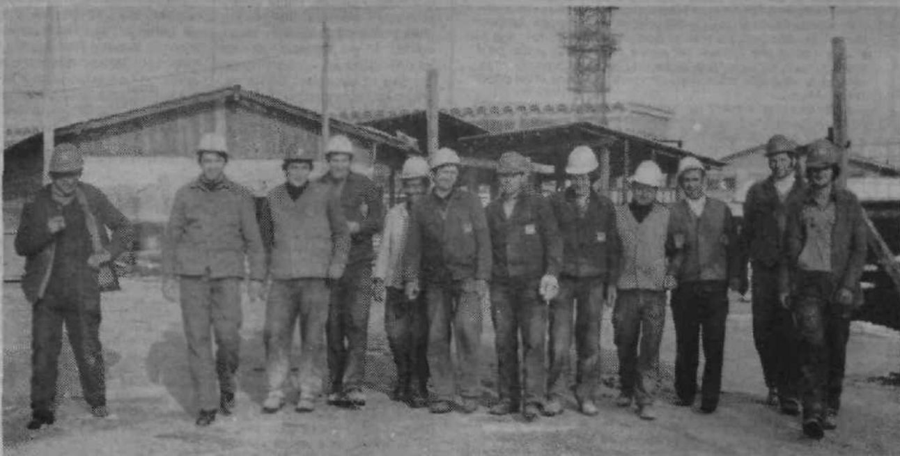
Skupina delavcev Splošnega gradbenega podjetja Grosuplje - sektor II je uspešno končala še en delovni dan, veseli se odpravljajo domov. Veliko jih še stanuje v barakah, ko pa bodo končali samski dom ob Topniški ulici za Bežigradom, od koder je naš posnetek, se bo večina vselila vanj in uživala sadove svojega pridnega dela. Dom so že spravili pod streho. Foto: IVAN ŠUČUR
