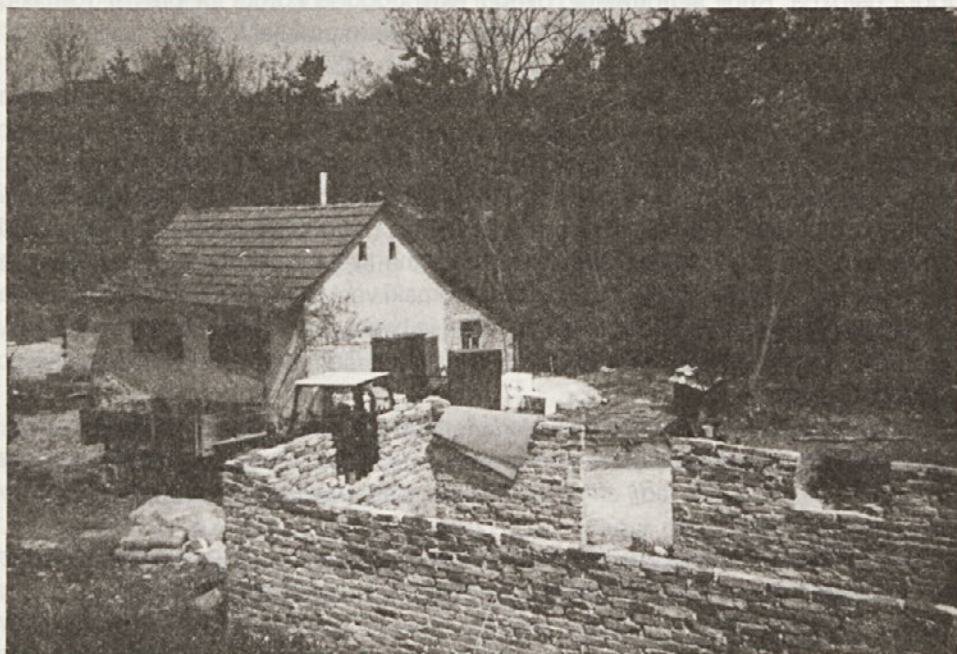
Pogled na novogradnjo romske stanovanjske hiše (foto: V. Huzjan).
