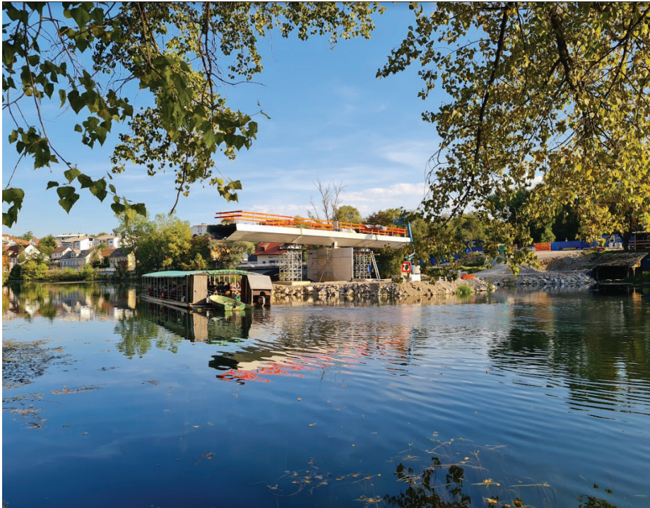
Slika 5. Montirani prvi trije segmenti in rečni promet med gradnjo (foto: Danilo Malnar).
