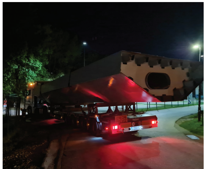
Slika 7. Izreden prevoz segmentov dolžine 14 m na delovišče preko mestnega jedra na levi breg reke Krke, september 2022 (foto: Danilo Malnar).
