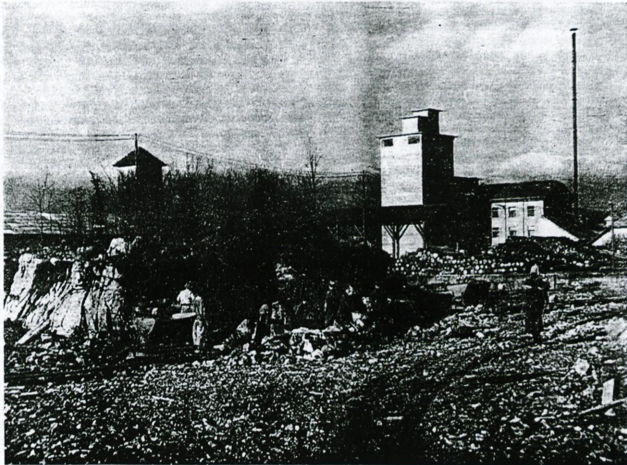
Izgradnja skladišča za rezan les
