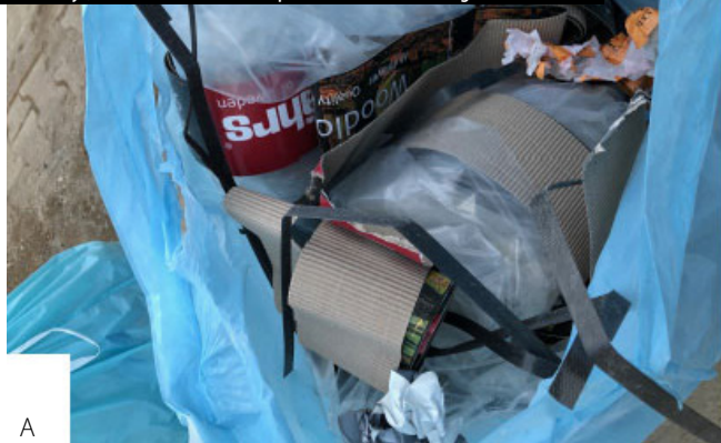
Slika 2: Odpadna embalaža pri vgradnji gradiv – (A) možnost sortiranja in recikliranja, (B) zaradi umazanosti posod embalaže ni mogoče reciklirati.
