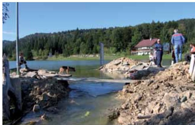
Cesto proti Hrušici na Kalcah so prekopali, da bi voda lahko odtekla, a je bilo preveč in je zalila cesto. (foto: Brane Pevec)
