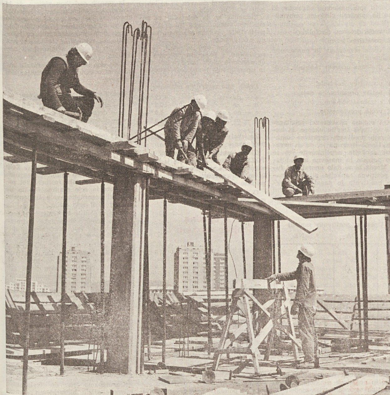
Gradnja novih prostorov za skupne službe
