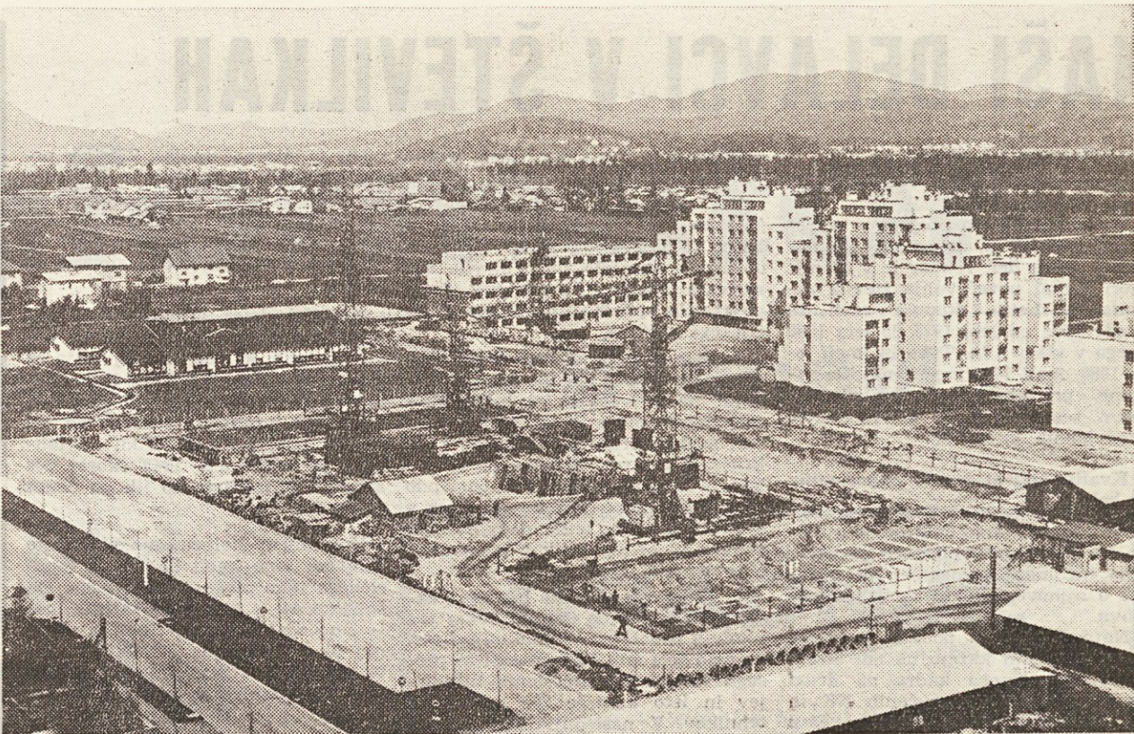
Gradnja v Novih Jaršah se nadaljuje
