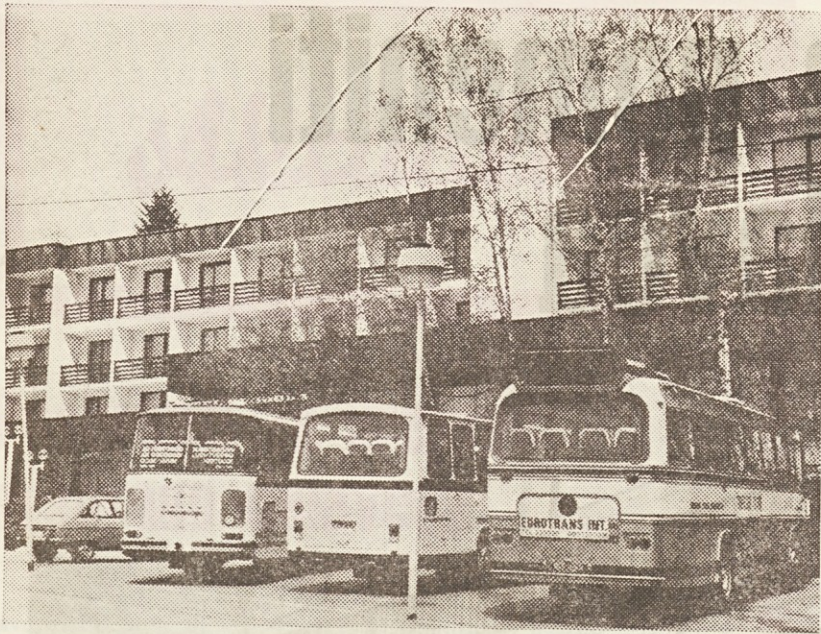
Hotel Svoboda je eden zadnjih objektov, ki smo jih gradili na Bledu
