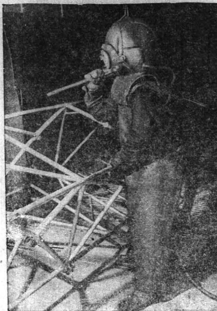
Na sliki je delavec, ki vari pločevinaste ploče na stranice podmornice. Radi duševnega ognja in vročine mora biti oblečen kakor kak potapljač.
