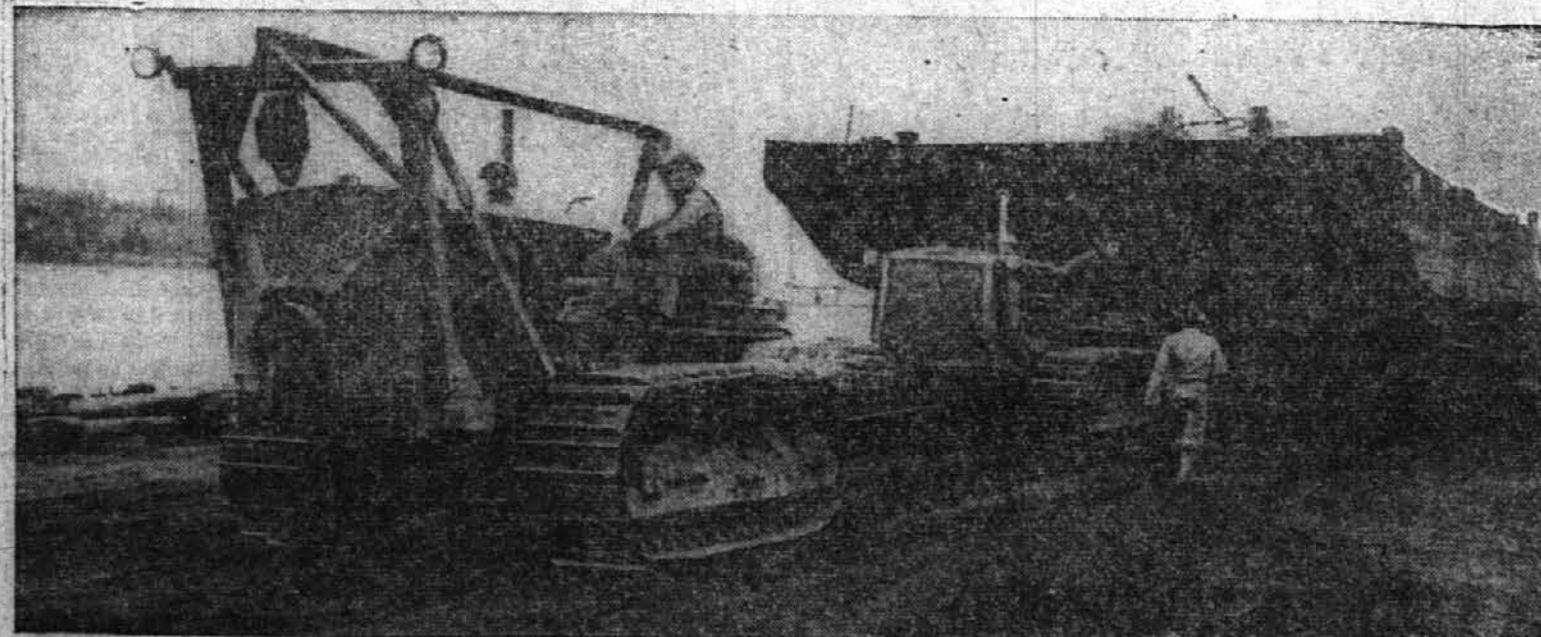
Ameriški inženirji gradijo cesto, ob kateri bodo položene tudi cevi za dobavo olja iz Fort Normana na severozapadu Kanado. Slika kaže del ceste, ki jo gradijo med Fort Smithom in Fitzgeraldom. Teži traktorji vlečejo velik rečni splav, ki ga bodo rabili za prevažanje materiala po reki, ob kateri teče cesta.
