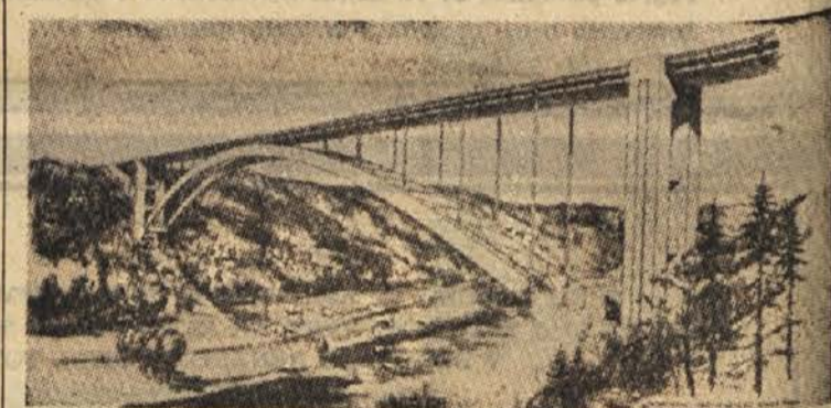
Cez vitavske brzice pri Orliku na Češkoslovaškem bodo zgradili most z največjim polnostenskim dvočlenskimi jeklenim lokom in z vozliščem zgoraj. Imel bo 330 m razpona. Doslej je veljal za največji most te vrste tisti nad Niagarskimi slapovi, kjer znaša največji razpon 289 m. — V celoti bo nov most, katerega maketo kaže naš posnetek, dolg 530 m.
