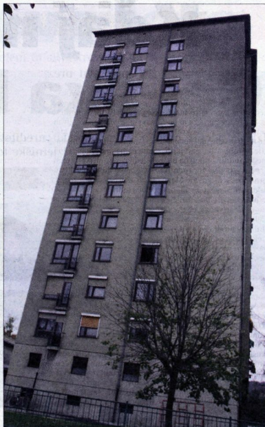
Stolpnica na Trubarjevi, ki ni potresno varna, naj bi predstavljala nevarnost za predvideni prizidek dnevnega centra dobriškega zavoda.
