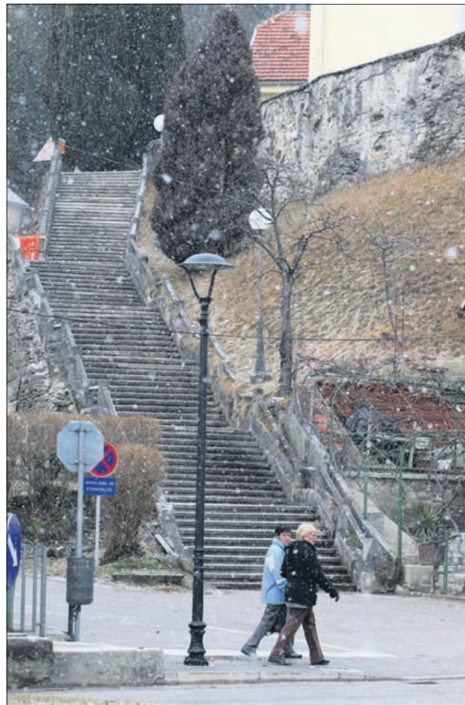
Pozimi so na Dobrni za dva meseca prekinili obnovo obzidja in stopnišča do cerkve Marijinega vnebovzetja, prihodnji teden pa bodo trije delavci režijskega obrata spet začeli delati.
