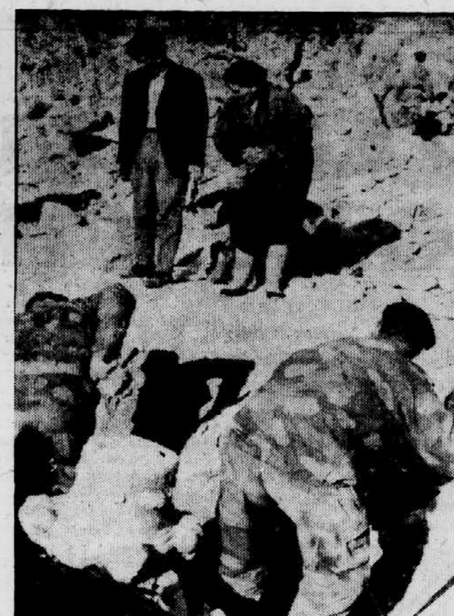
TU NI TRUPEL: samo po značilnih predmetih lahko vojači približno ugotovijo, kaj je pred usodno nočjo na nekem mestu stalo. Tu je bila cerkev, sedaj pa je ostal med kamnito grobljo samo del stebra.
