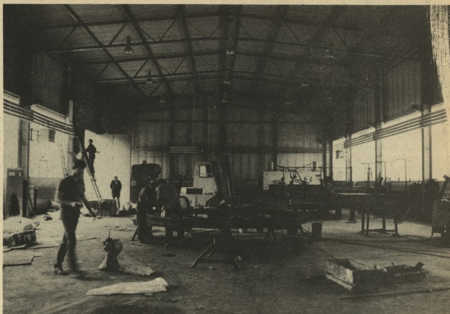
Čeprav novozgrajena tovarniška dvorana do IMD tozda SIMD na Gvidi še ni v celoti končana, se dela v njej že odvijajo. (Foto: B. Klančar)
