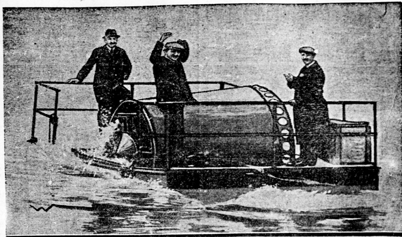
VAŽNA IZNAJDBA. Inž. W. Sness je iznašel turbino, ki s pomočjo skorzi tekoče vode proizvaja potom propelerja električno moč, ne da bi zavirala plovbo. — Slika kaže tako turbino v trenot ku, ko se potaplja.
