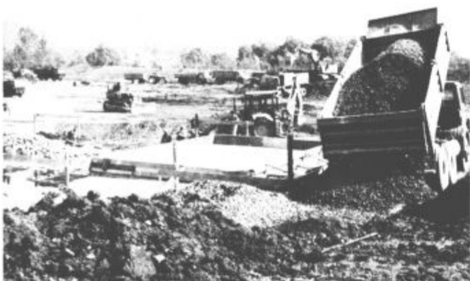
Na gradbišču odžvepljevalne naprave četrtega bloka poteka vse po zastavljenem planu
