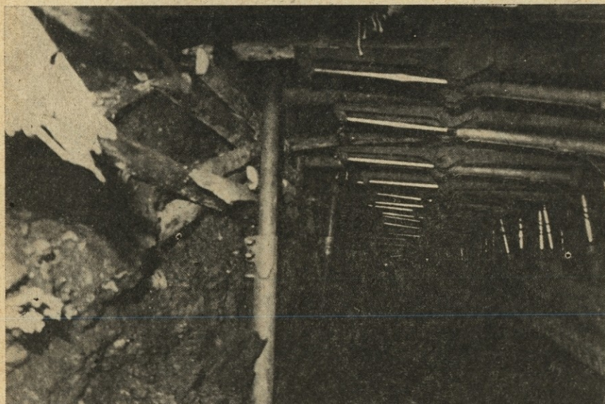
Na odkopnem čelu jame premogovnika Trbovlje — AB polje, samohodno hidravlično podporje Hydro Marrel.
