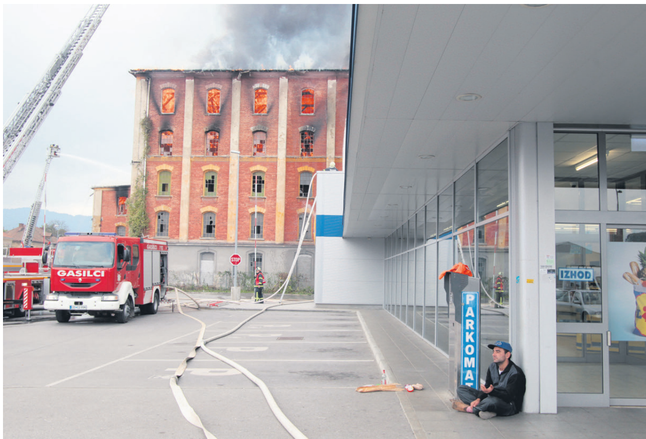
Cesta med Rakuševim mlinom in trgovskim centrom Lidl ostaja do nadaljnjega zaprta. Zaradi silovitosti požara je izvedenec gradbene stroke ugotovil močne poškodbe stavbe in napovedal možnost hipne porušitve, a ožgano zidovje je doslej uspešno kljubovalo vremenu.
