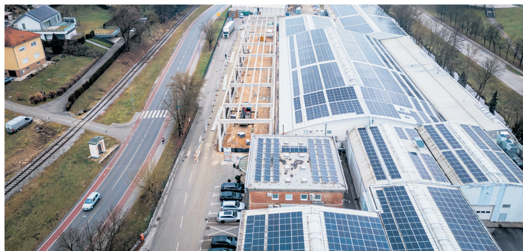
Atlantic Grupa se je lotila obnove dela polnilnice v Rogaški Slatini. Leta 2023 je na preostanku strehe slatinske polnilnice zagnala sončno elektrarno z močjo 974 kWp, ki na letni ravni proizvede približno eno gigavatno uro električne energije, oz. več kot 30 odstotkov potreb po električni energiji v polnilnici.
