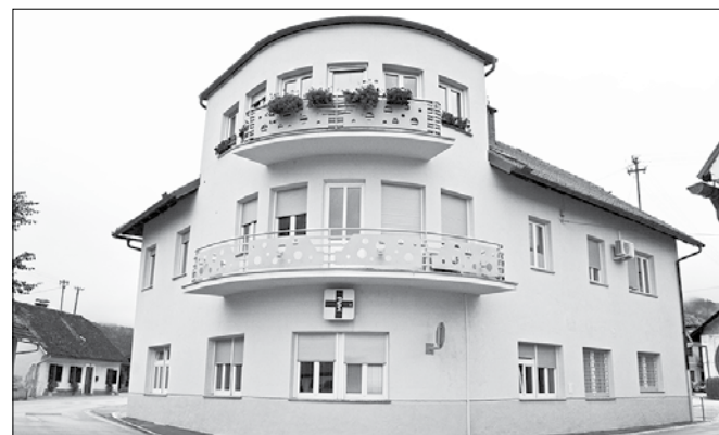
Potem ko je Občina Ljubno pred nekaj leti prenovila zunanost zgradbe zdravstvenega doma in lani v njem uredila tudi referenčno ambulanto, je zdaj prenove deležna še splošna ambulanta. (Foto: Marija Lebar)
