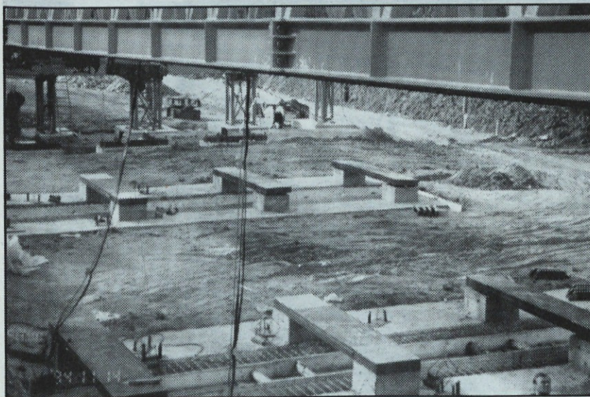
Viadukt 60-26 — priprave za izdelavo "mokrega stika" 40 metrov dolgih nosilcev
