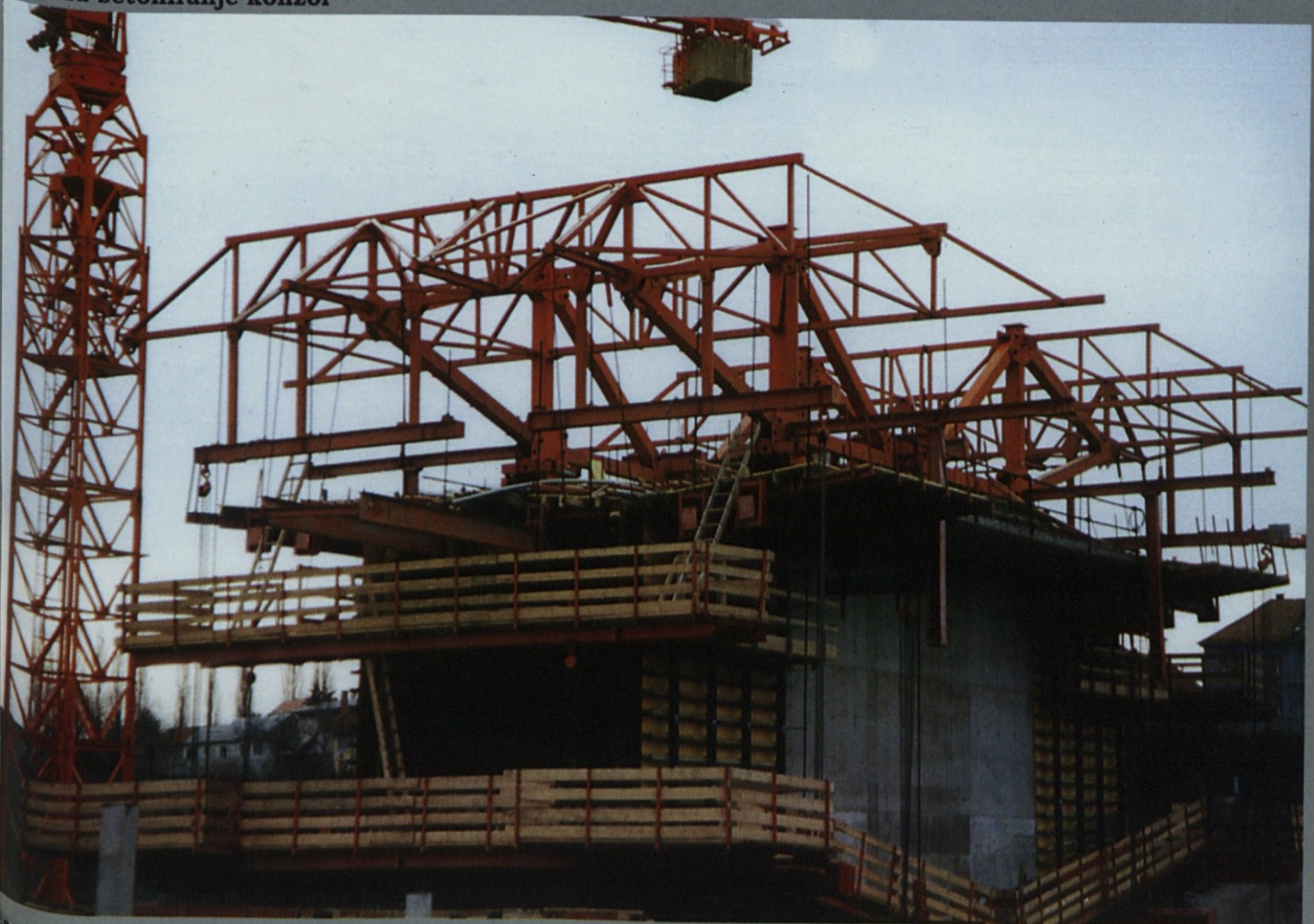
Viadukt 60-24 Škedenj 1 na AC Hoče-Arja vas — priprave odrov za betoniranje lamel
