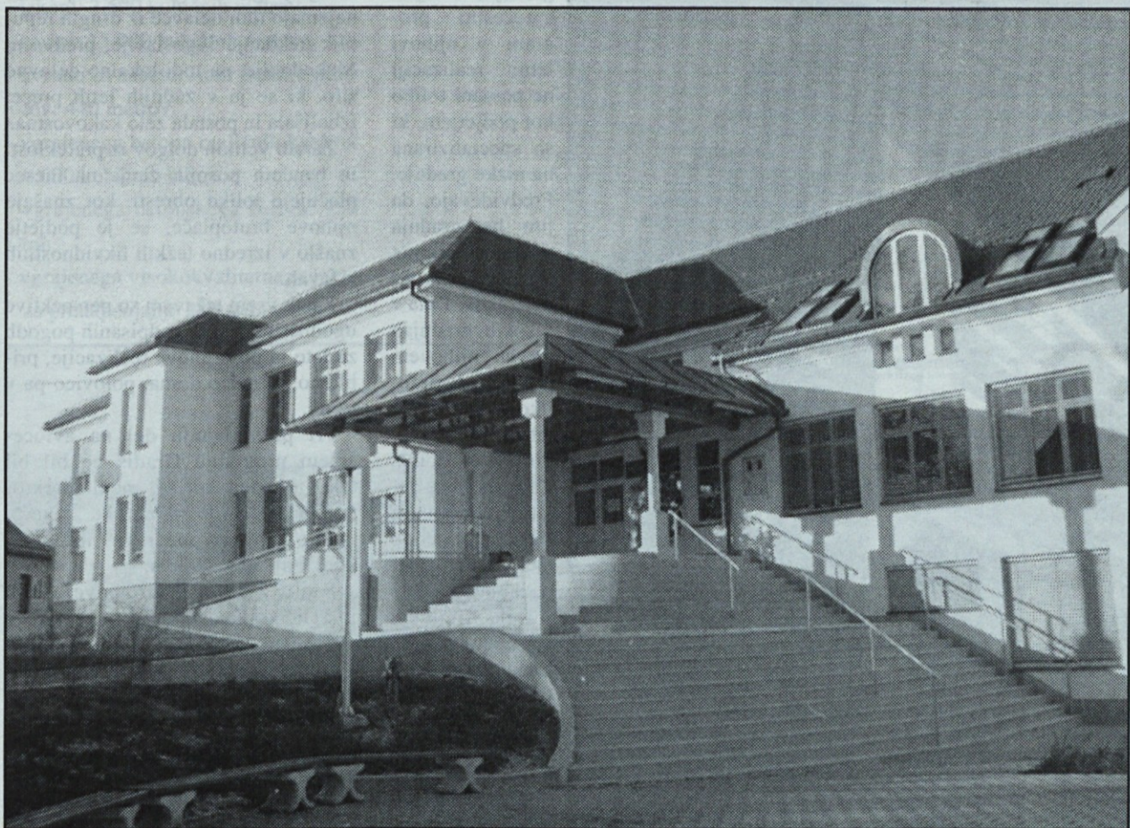
Stari del šole v Vidmu (levo od nadstreška nad vhodom) je po obnovi prav tako lep kot prizidek.
