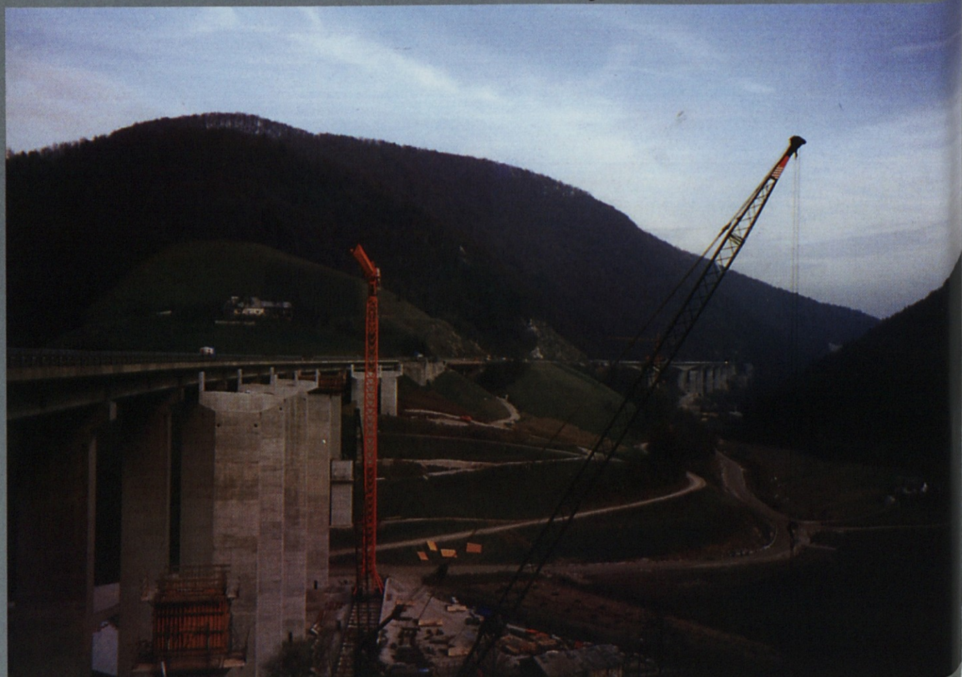
Škedenjska dolina na AC Hoče-Arja vas Gradnja Viaduktov 60-24, 60-25 in mostu 50-41
