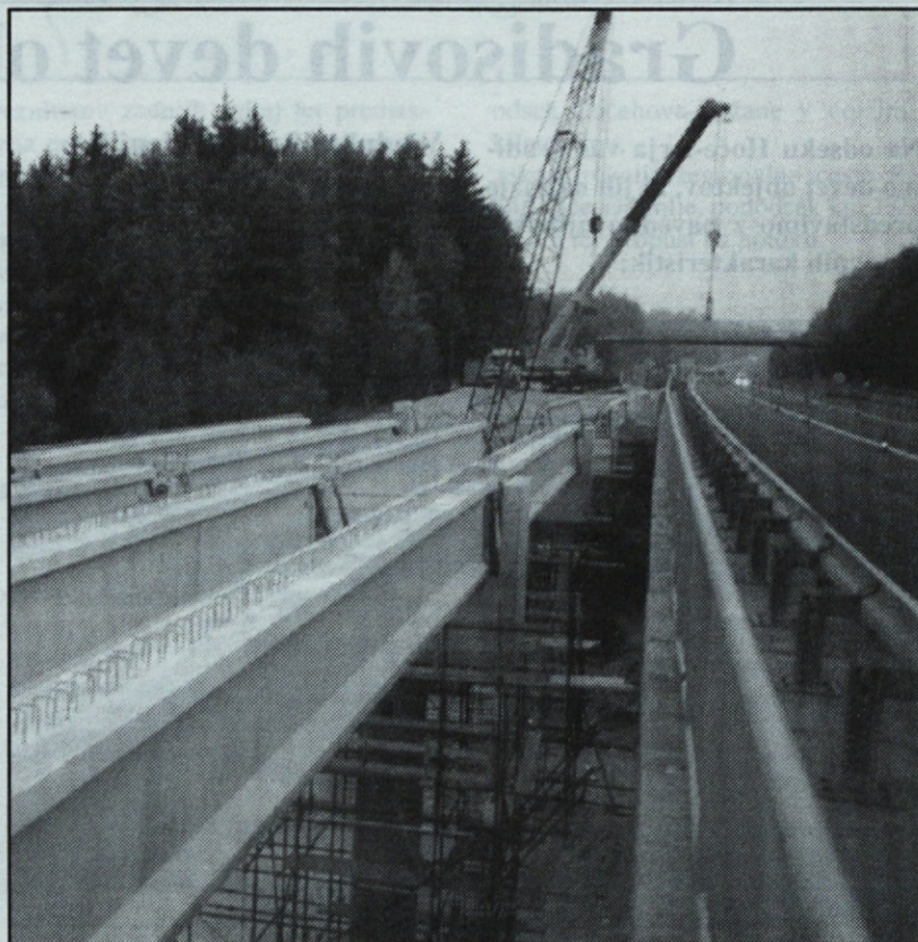
Viadukt 60-27 — montaža zgornje konstrukcije viadukta
