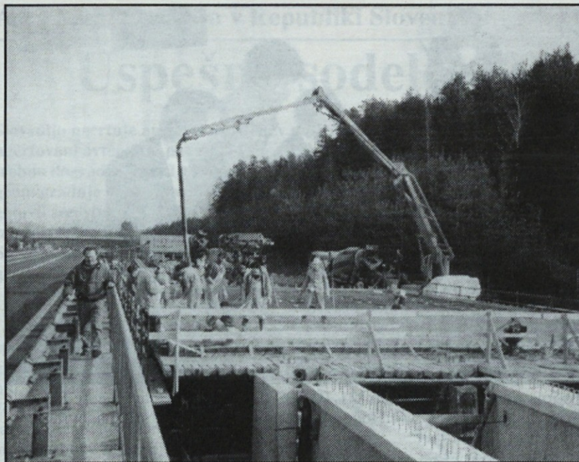
Viadukt 60-27 — betoniranje voziščne plošče
