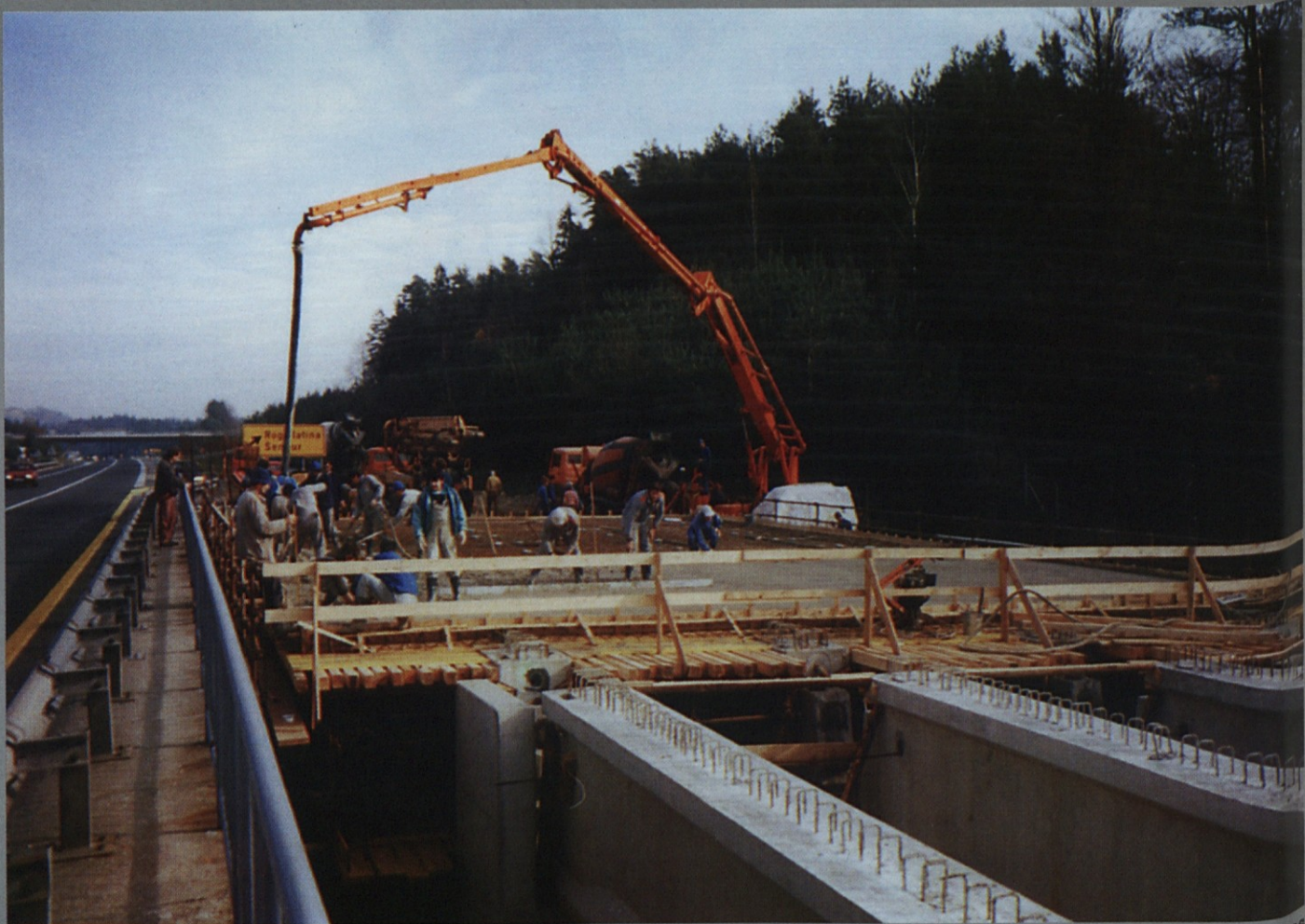
Viadukt 60-27 Dramlje na avtocesti Hoče-Arja vas Betoniranje voziščne plošče
