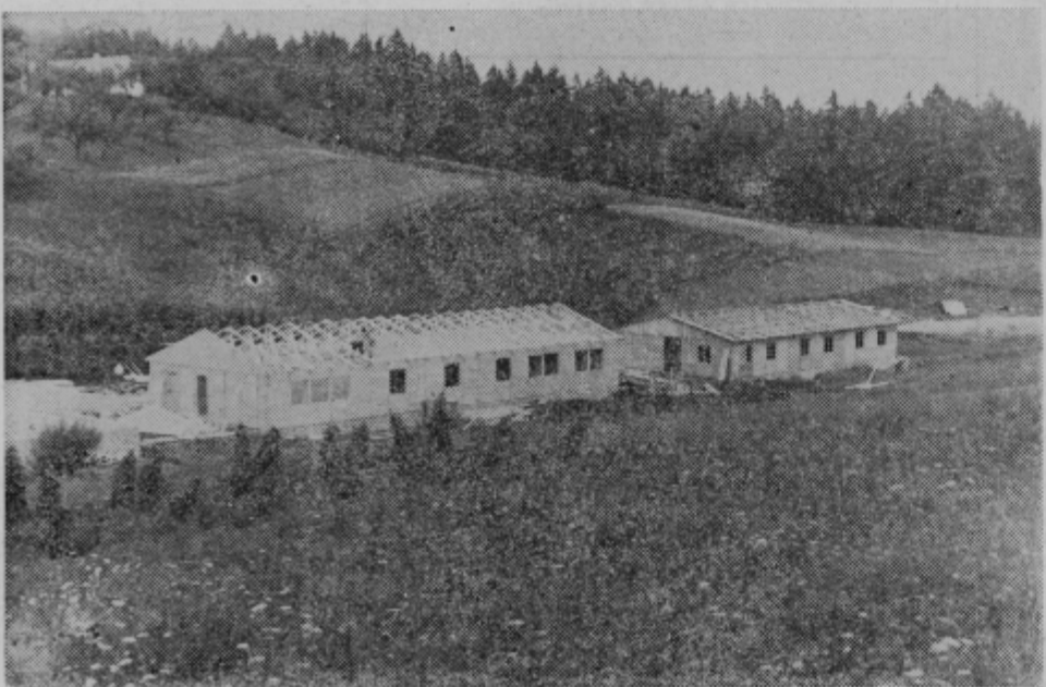
VELIKE PRIPRAVE — za gradnjo hitre ceste. Posnetek je narejen pri Žičah, temelje za barake pa je naredilo gradbeno podjetje Ingrad iz Celja za delavce trboveljskega RUDISA, ki bo v bližini gradilo velik predor za hitro cesto. Prve lastovke so priletele ... (Foto: D. Medved)
