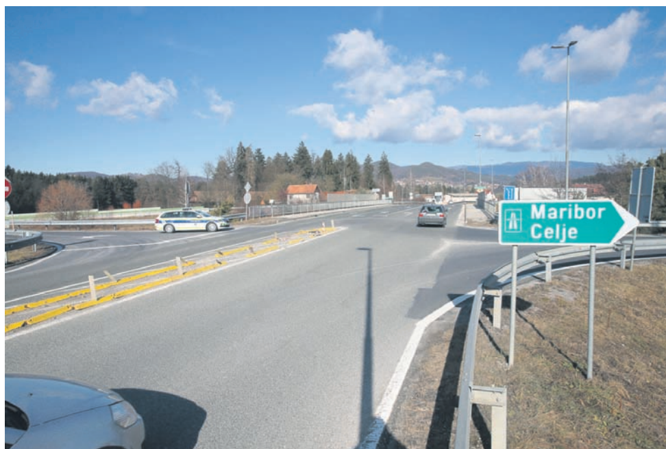
Ena najbolj perečih prometnih točk ne samo v občini Žalec, temveč tudi na celotni avtocesti med Celjem in Ljubljano je zagotovo priključek v Arji vasi. Zaradi zastarele oblike diamanta je nepregleden in nevaren, ob njem pa že zdaj, ko bližnja poslovna cona ni niti še dokončno zaživela, nastajajo zastoji.
