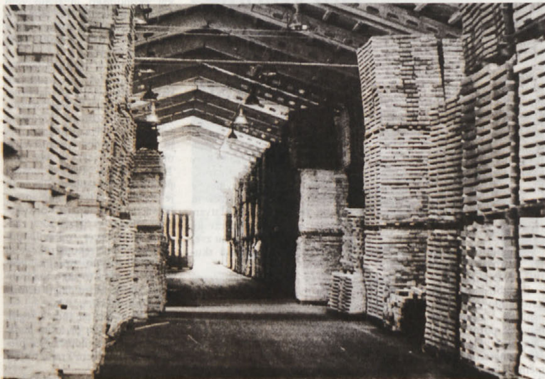
Notranjost pokritega skladišča decimeranega lesa, ki je končno dobilo streho.
