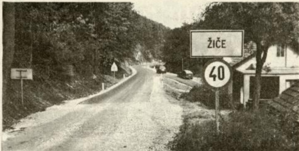
400 metrov novega asfalta na cesti Žiče-Spitalič za tolažbo krajanom, ki so zaradi te ceste že večkrat obljubljali zaporo avtoceste Hoče-Arja vas.
