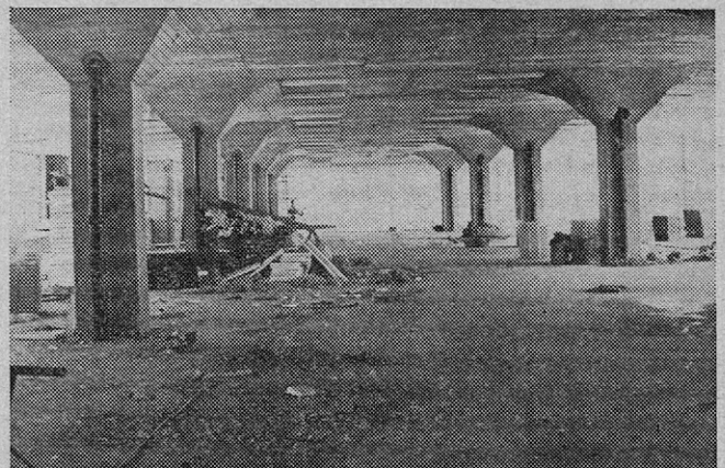
Zgornji posnetek je del nove stavbe, na spodnjem pa vidite prostor novih šivalnic.
