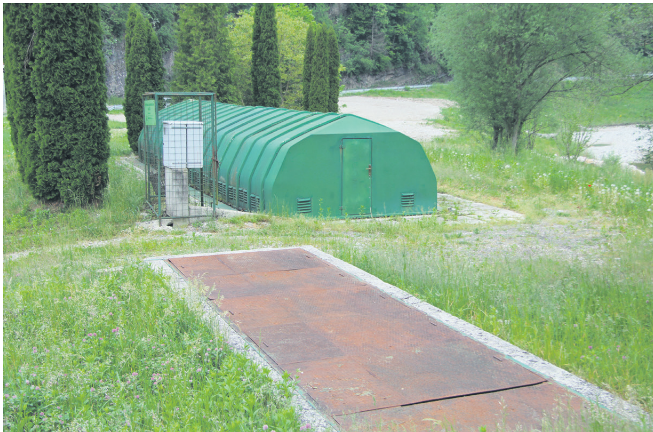
Obstoječa čistilna naprava za Luče je dotrajana in zastarela. Novo želijo postaviti v neposredni bližini, vendar na vodno soglasje čakajo že skoraj štiri leta.
