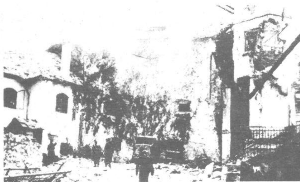
Porušeni grad Turjak
