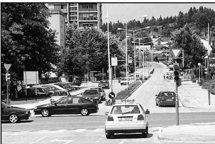
Kidričeva cesta, od križišča pri nakupovalnem centru, bo kmalu dobila številne nove semaforje. Ti sicer že stojijo, zgrajena je tudi nova avtobusna postaja, delovati pa bodo pričeli jeseni. Bodo razdalje med semaforji res premajhne, kot se sprašujejo mnogi občani? Pokazal bo čas in praksa.
