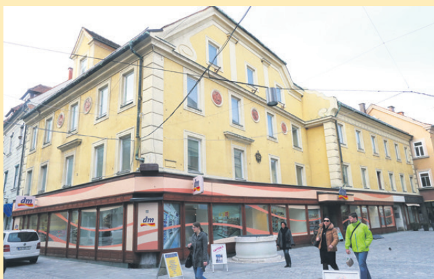
Prostori nekdanje trgovine Moda, ki so prazni nad trgovino DM. Stavba je v lasti PSZ. Poslovni sistem Zupanc. Dražba bo naslednji mesec. Stečajni upravitelj pravi, da je zanimanje le za nakup pritličnih prostorov, vendar bo stavbo prodajal kot celoto. Izključna cena je 850 tisoč evrov.
