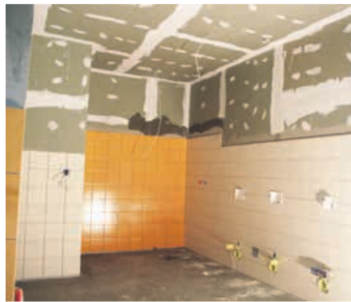
Polaganje keramike v sanitarnih prostorih.
