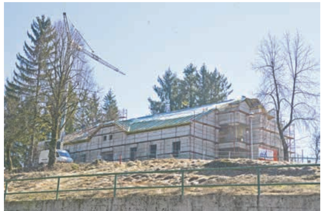
Po tridesetih letih je postalo območje nekdanje vojašnice končno zanimivo za investitorje. Trenutno se tam gradi enota za varstvo starejših Doma upokojencev Vrhnika. V bližini je načrtovan še oddelek za demenčne.
