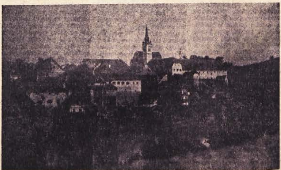
Novo mesto pred zgraditvijo novega mostu
