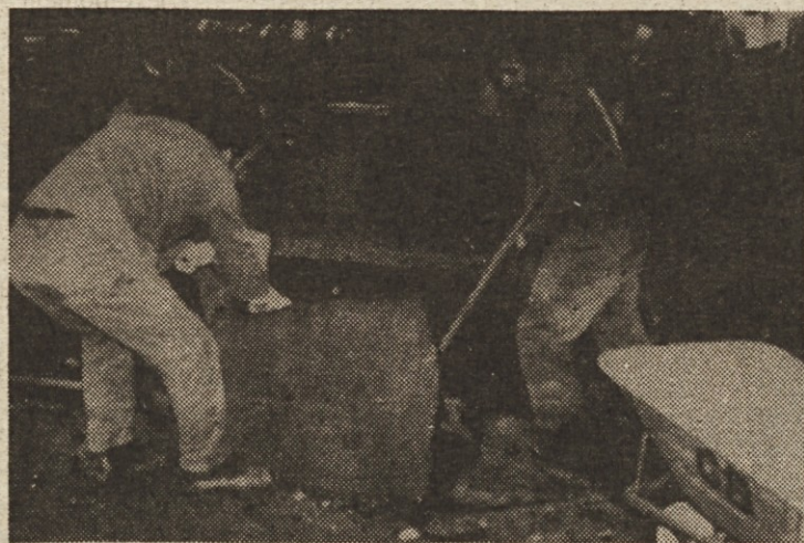
Pri betoniranju tal so pomagali tudi delavci iz proizvodnje.
