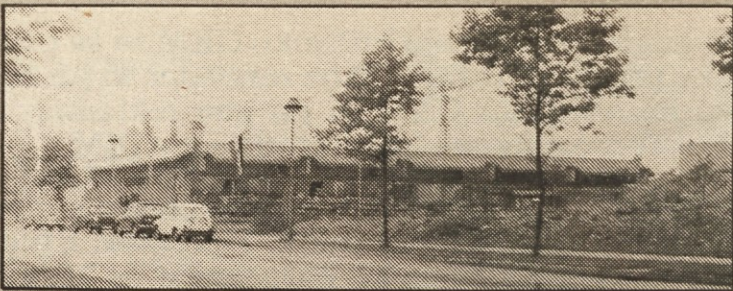
Samopostrežna trgovina na ulici Bratov Babnik je obdana z žerjavi in hribi gradbenega materiala.
