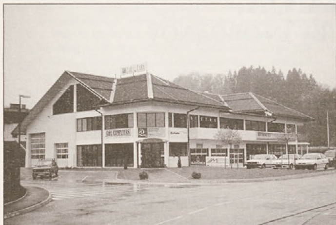
Pogled na objekt Tehničnoservisnega centra Laba
