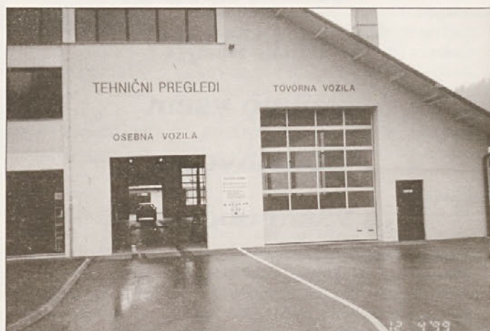
Vhod v prostore, kjer je bilo lani opravljenih 6000 tehničnih pregledov
