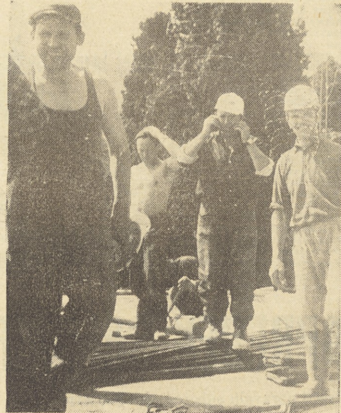
Zal nam je v objektiv uspelo ujeti le štiri izmed nešteto pridnih graditeljev
