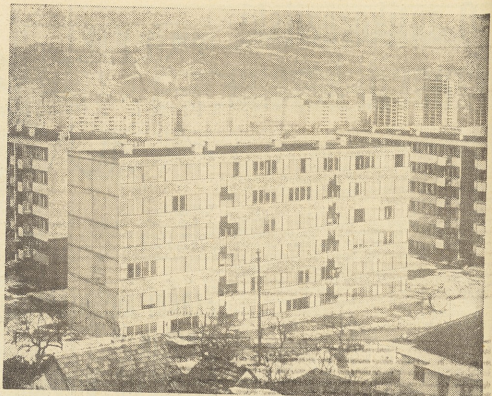
Objekt, ki ga je podjetje »Vranica« zgradilo na »Čengić Vili« v Sarajevu. V njem je 36 stanovanj, gradili pa so ga osem mesecev
