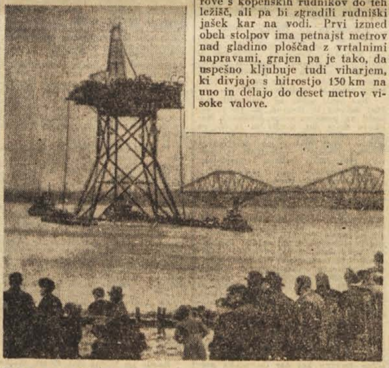
Takole so peljali prvi vrtalni stolp, s katerim bodo v bližini škotske obale iskali ležišča premoga na morskem dnu.
