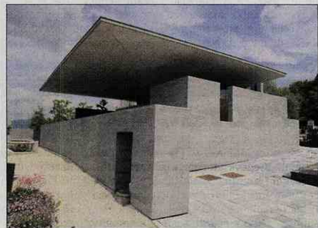
Na pokopališču Teharje so ob sofinanciranju Občine Štore prenovili še poti, vežico pa priključili tudi na kanalizacijo.
