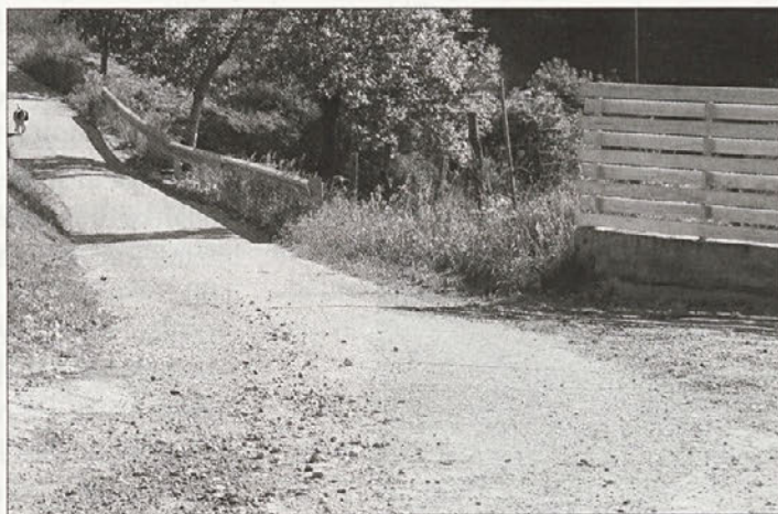
Na prenovo in temeljito preplastitev čaka tudi cestni odsek Milošič v Gradiščah.
