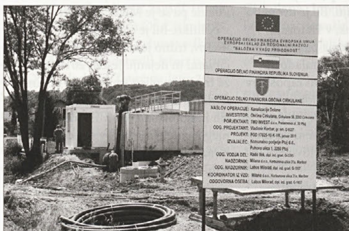
V investicijo v Dolanah je vključena tudi izgradnja biološke čistilne naprave.
