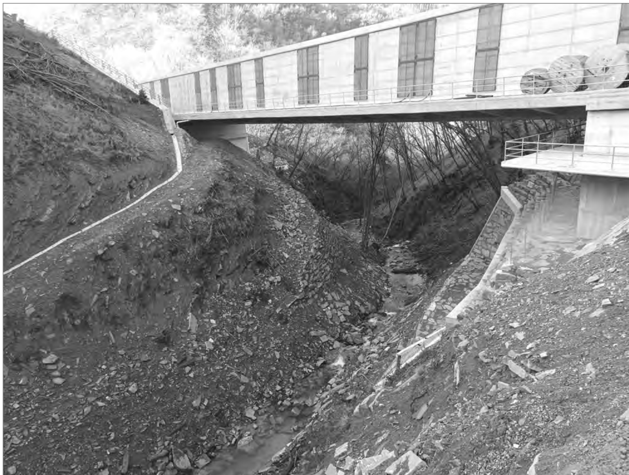
Slika 6: Vzpostavljeno sonaravno stanje struge Glinščice po izgradnji viadukta (foto: Arhiv ZRSVN, Območna enota Nova Gorica, 11. 1. 2023)
