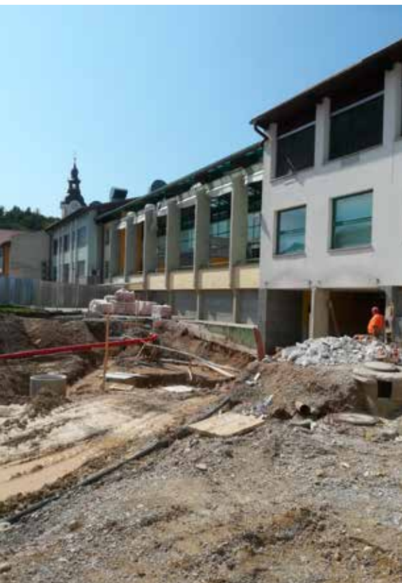
Gradbena jama za prizidek na Govekarjevi (II. faza)
