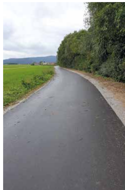
Novoasfaltirana cesta v Tomišlju
