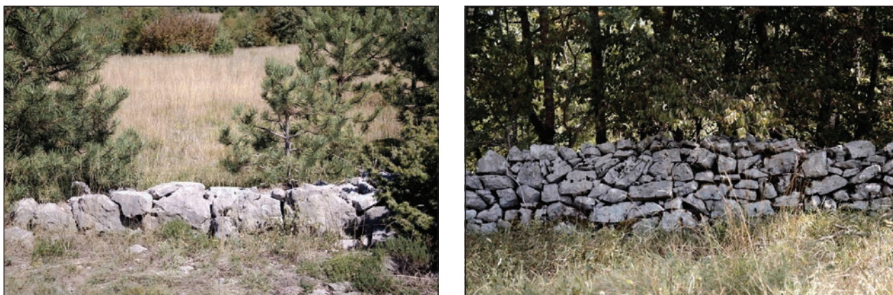
Slika 4: Leva slika je primer suhega zidu severnega dela Divaškega krasa, desna pa primer suhega zidu iz južnega dela (Fotografiji: Urška Valenčič, avgust in oktober 2013)
